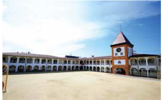
すみれ幼稚園(京都市山科区)
